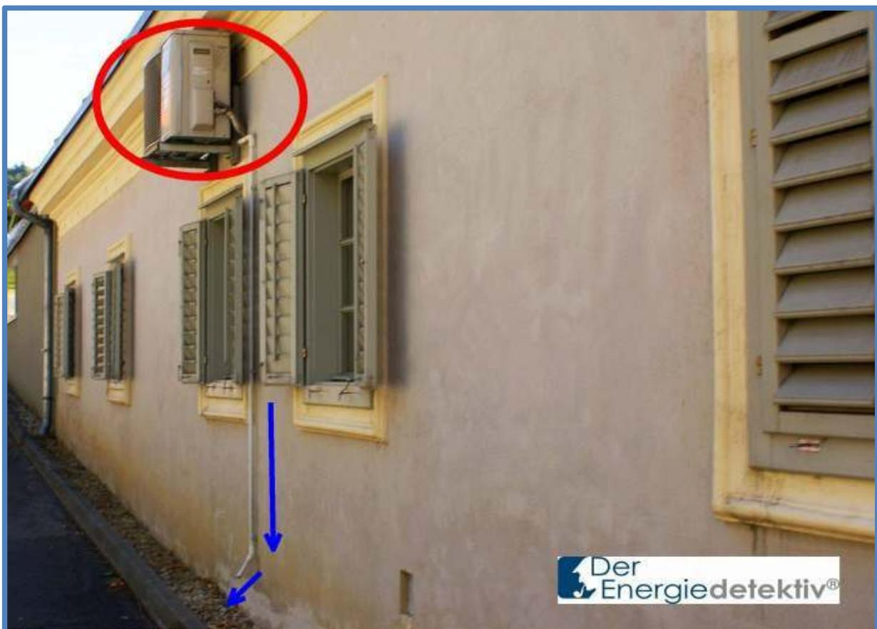
*Bild 134: auch Klimaanlage führen zu einer Umverteilung von Wasser aus der Luft in vegetationsloses Erdreich, wie hier bei einer Nachrüstung in einem Altbau. Damit wird gerade an heißen Tagen der Luft Feuchtigkeit entzogen. Hier versickert das Wasser im Schotterbereich an der Mauer. Meist erfolgt eine geschlossene Ableitung, womit das Wasser unbeobachtet bleibt. Weniger Feuchtigkeit in der Atmosphäre bedeutet gleichzeitig aufgrund verringerter Dämpfung stärkere Sonneneinstrahlung*
