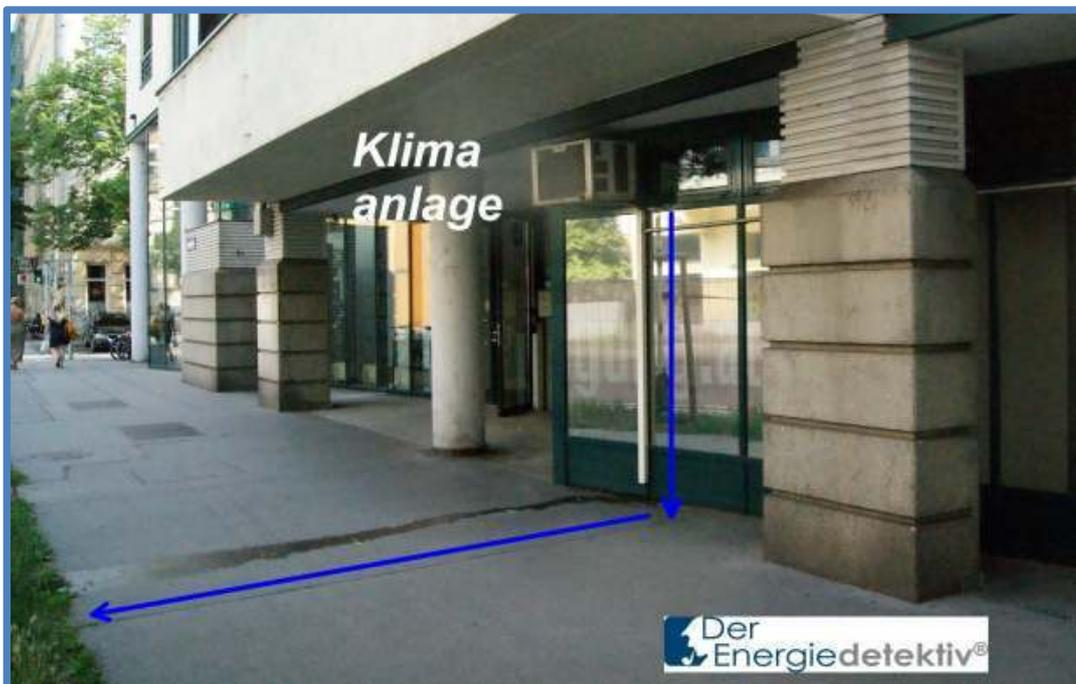
*Bild 135 und 136: Im Sommer werden die beachtlichen Kondensatmengen auch bei Kleinanlagen manchmal erkennbar: in diesem Fall erfolgt die Ableitung nicht wie gefordert in den Kanal sondern auf den Gehsteig. Es entsteht ein kleines, ständig gespeistes Bächlein, dass am Ende doch die Vegetation am Straßenrand erreicht*
