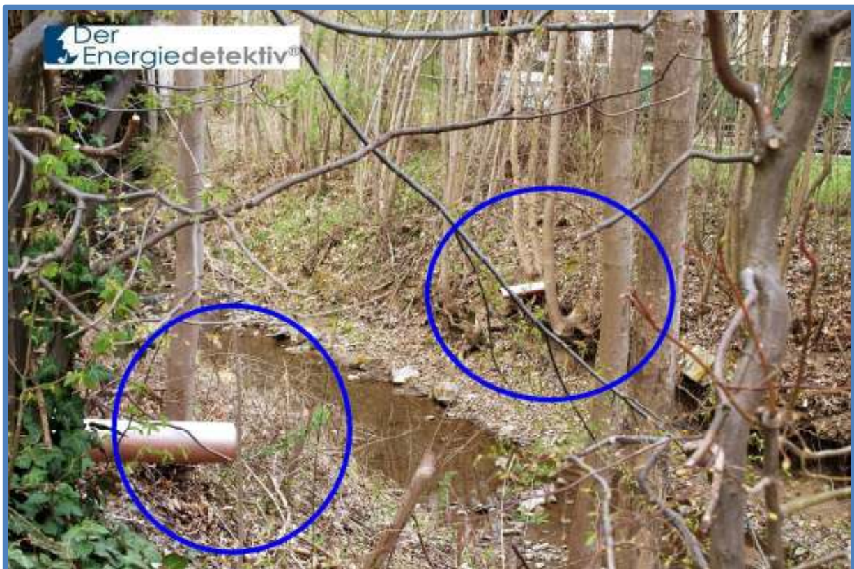
Bild 96: Wasser aus Drainage-Anlagen entwässern Grundstücke rund um Gebäude und werden in den nächsten Bach eingeleitet. Damit sind auch Niederschläge, die eigentlich auf Grünflächen niedergehen, am Umverteilungsvorgang beteiligt. Unzählige derartige Anlagen tragen zur Klimaänderung bei
