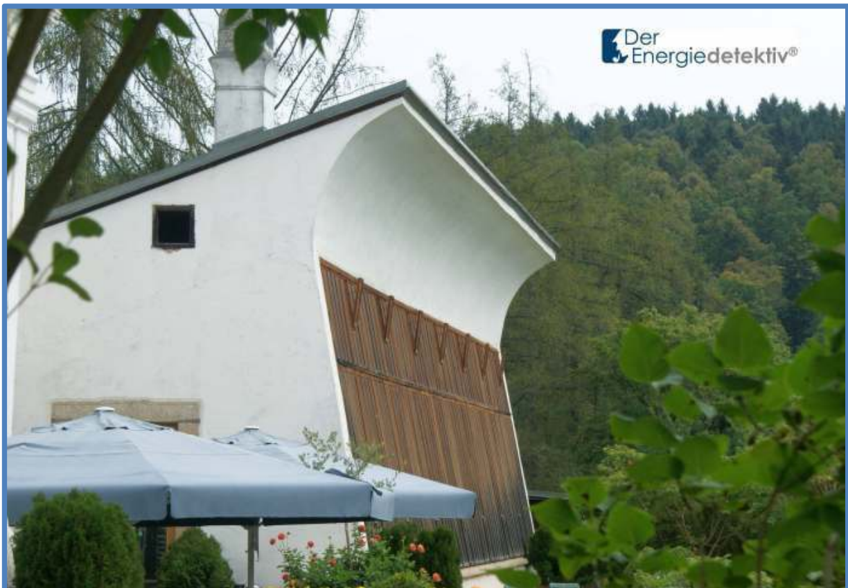
Bild 13: Der Blick nach Osten zeigt eine Front des Gewächshauses
