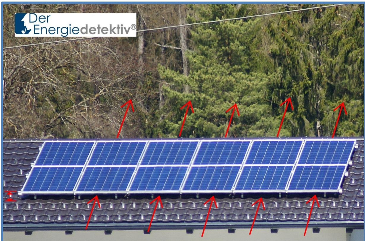
*Bild 12-32: Diese Photovoltaikanlage wurde wenige Zentimeter abgesetzt über einem schrägen Dach angebracht. Luft kann an der Unterseite der Photovoltaikanlage durchstreichen und kühlen. Abwärme wird sowohl an der Unterseite als auch an der Oberseite an vorbeiströmende Luft abgegeben*
