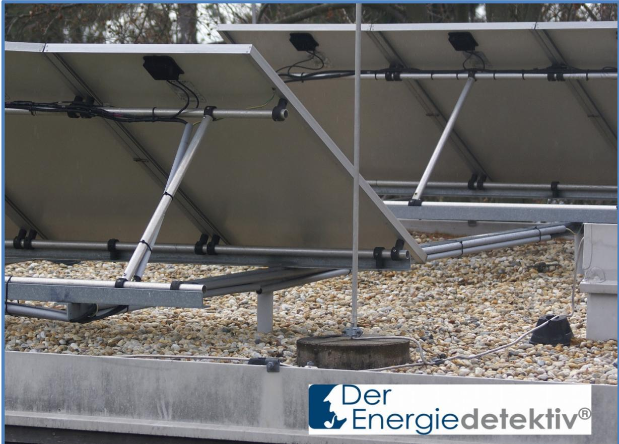
*Bild 12-28: Zu beachten ist die unterschiedliche Absorptionsrate an einer Photovoltaikanlage im Gegensatz zur üblichen Kiesfläche auf Flachdächern*
