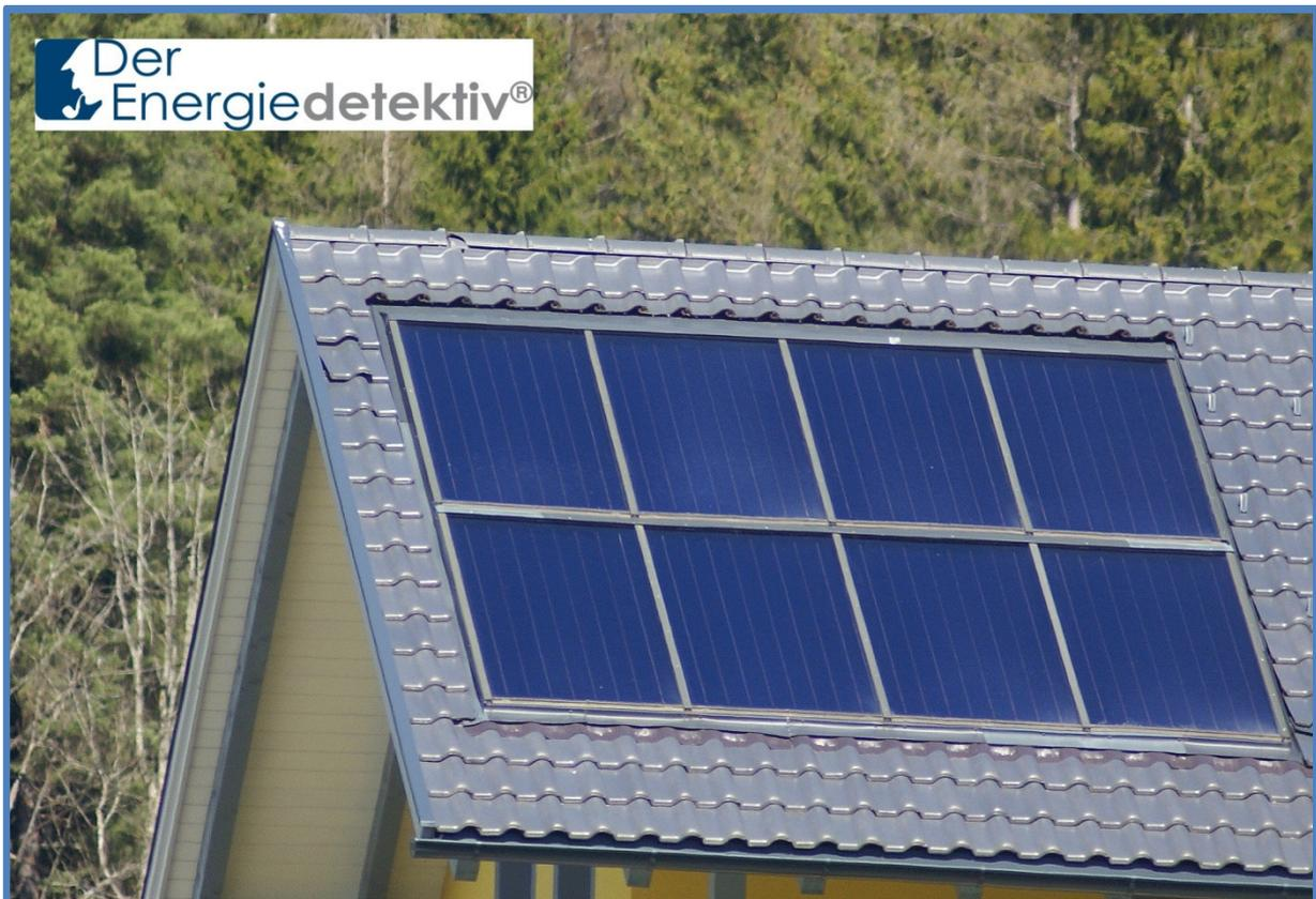
*Bild 12-29: thermische Solaranlage, die in die Dachdeckung direkt integriert ist*
