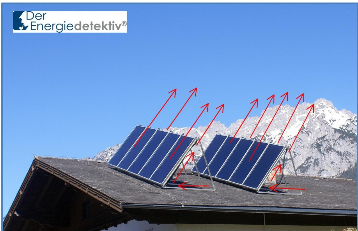
*Bild 12-33: Solarflächen, die am Dach aufgeständert werden, weisen eine höhere Windbelastung auf und geben auch Abwärme an die Luftströmung ab*
