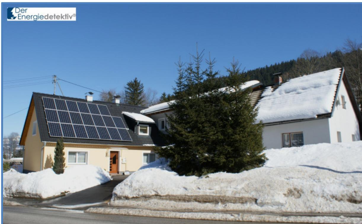
*Bild 8-27: Hier kommen über kurz oder lang die Fichten des kleinen Waldes sowie die vor dem Haus gepflanzte Konifere mit der Photovoltaikanlage in Konflikt.*
