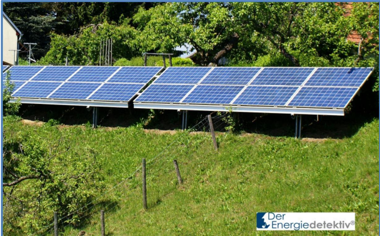
*Bild 8-75: eine Photovoltaikanlage in Hanglage, im Schattenbereich ist der Vegetationsverlust erkennbar*
