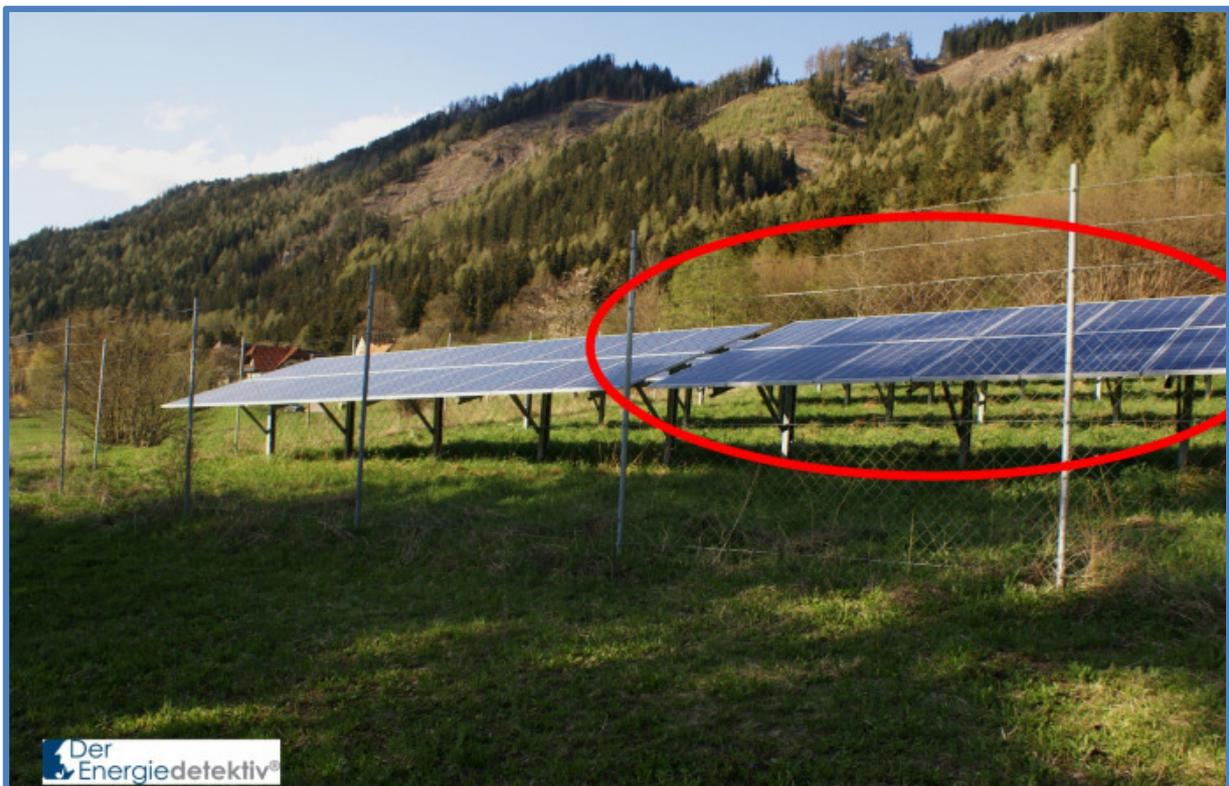
*Bild 8-41: vom Schattenwurf der Bäume am Nachbargrund werden durchaus größere Bereiche der Solarmodule beeinträchtigt*
