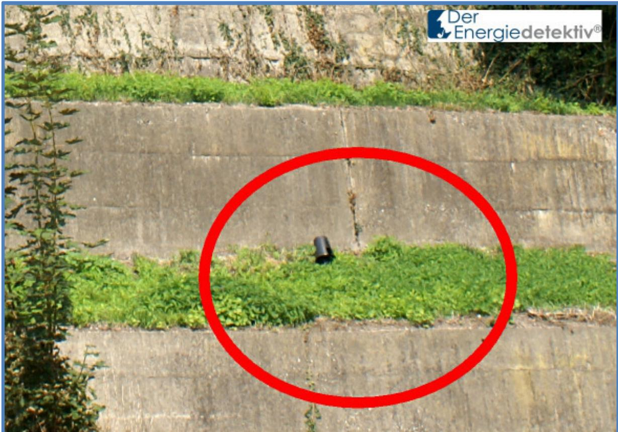
*Bild 8-115: in der Detailaufnahme wird klar was den heißesten Punkt in Bild 8-114 verursacht. Es ist ein alter Pflanztopf aus schwarzem Kunststoff. Er absorbiert die meiste Energie, die dann als Infrarotstrahlung im Wärmebild sichtbar wird*
