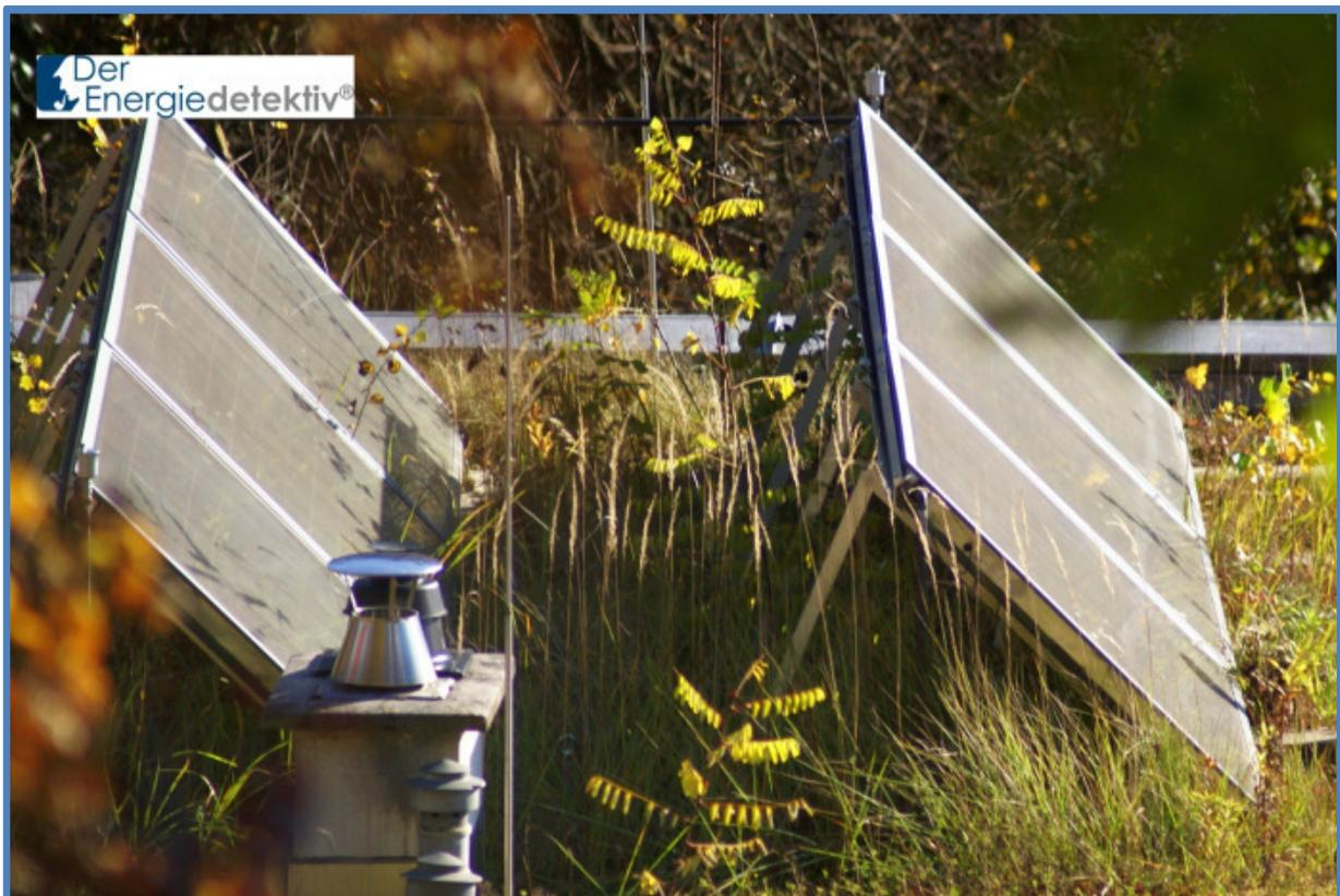
*Bild 8-17 die Vegetation rund um die Solaranlage Ende Oktober in einer weiteren Aufnahme. Es zeigt sich, dass massives Wachstum zwischen den beiden Kollektorfeldern stattfand*
