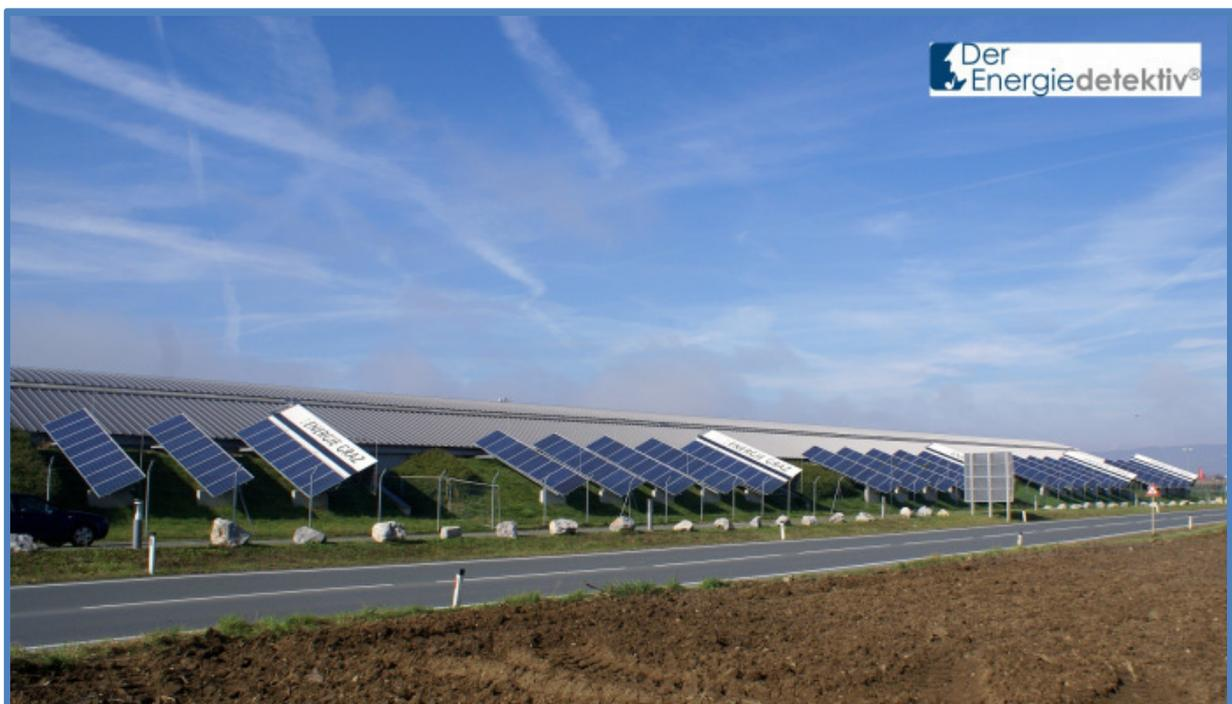
*Bild 8-32: auch Großanlagen wie hier eine Photovoltaikanlage am Flughafen Graz mit 280 m<sup>2</sup> Modulfläche können vom Wachstum der Vegetation beeinträchtigt werden*
