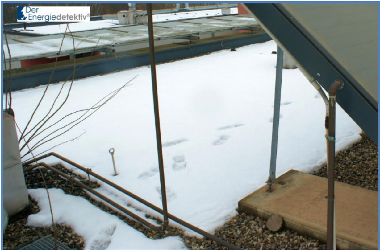
*Bild 8-19: entlang der nicht gedämmten Leitung einer Solaranlage ist der Schnee geschmolzen.*
