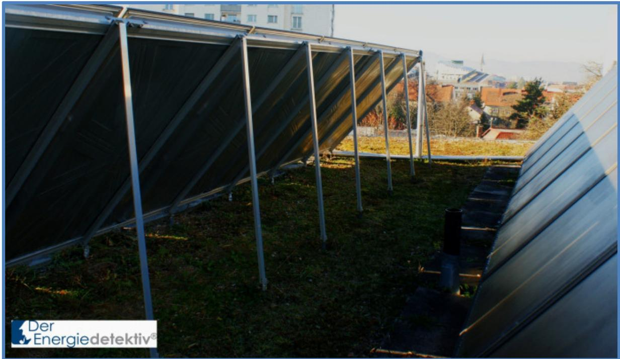
*Bild 8-14: Die zu enge Aufstellung der Solarfelder führt zur beobachteten Verschattung. Die halbe Kollektorfläche ist um 11 h verschattet.*
