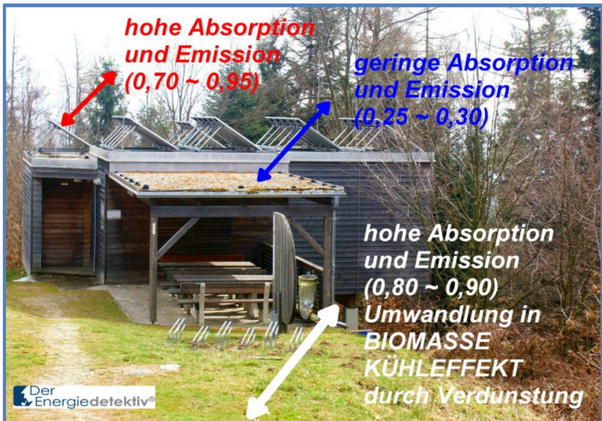
*Bild 8-165: Solaranlagen auf kiesbedeckten Flachdächern finden eine andere Ausgangssituation vor. Ein heller Kiesbelag absorbiert wesentlich weniger Solarenergie und ergibt geringere Wärmebelastung samt Wärmestrahlung. Vegetationsflächen bilden Biomasse und tragen zur sommerlichen Kühlung bei*
