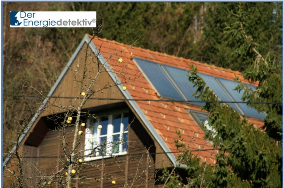
*Bild 8-9: Eine thermische Solaranlage östlich von Graz*
