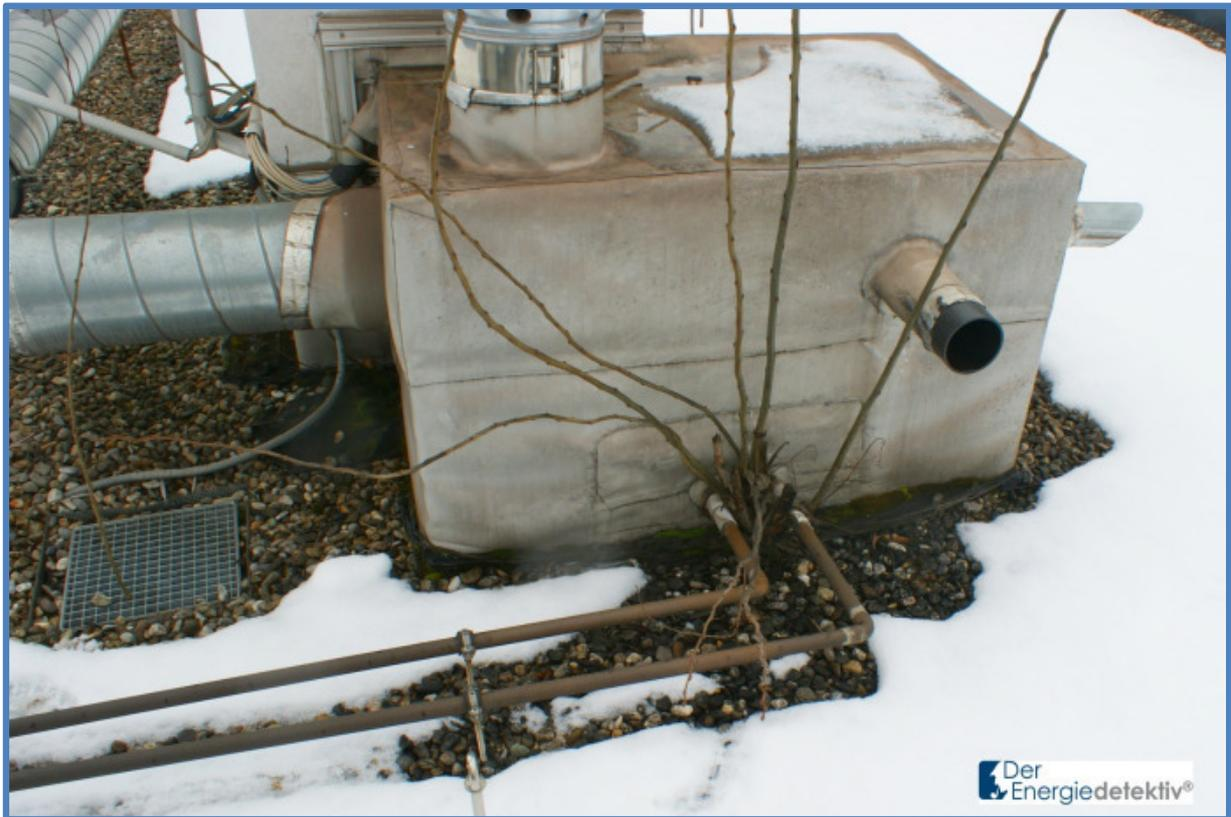
*Bild 8-20: Klimanutzen einer thermischen Solaranlage – gleich am Dach wird durch nicht gedämmte Leitungen das Wachstum von „Biomasse“ in Form eines kleinen Strauches angeregt*
