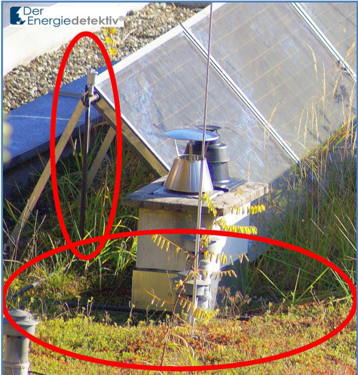
*Bild 8-18: Der vergrößerte Ausschnitt lässt vermuten, dass die heißen Kupferrohre, die die Solaranlage mit der Heizungsanlage verbinden, nicht wesentlich gedämmt wurden*
