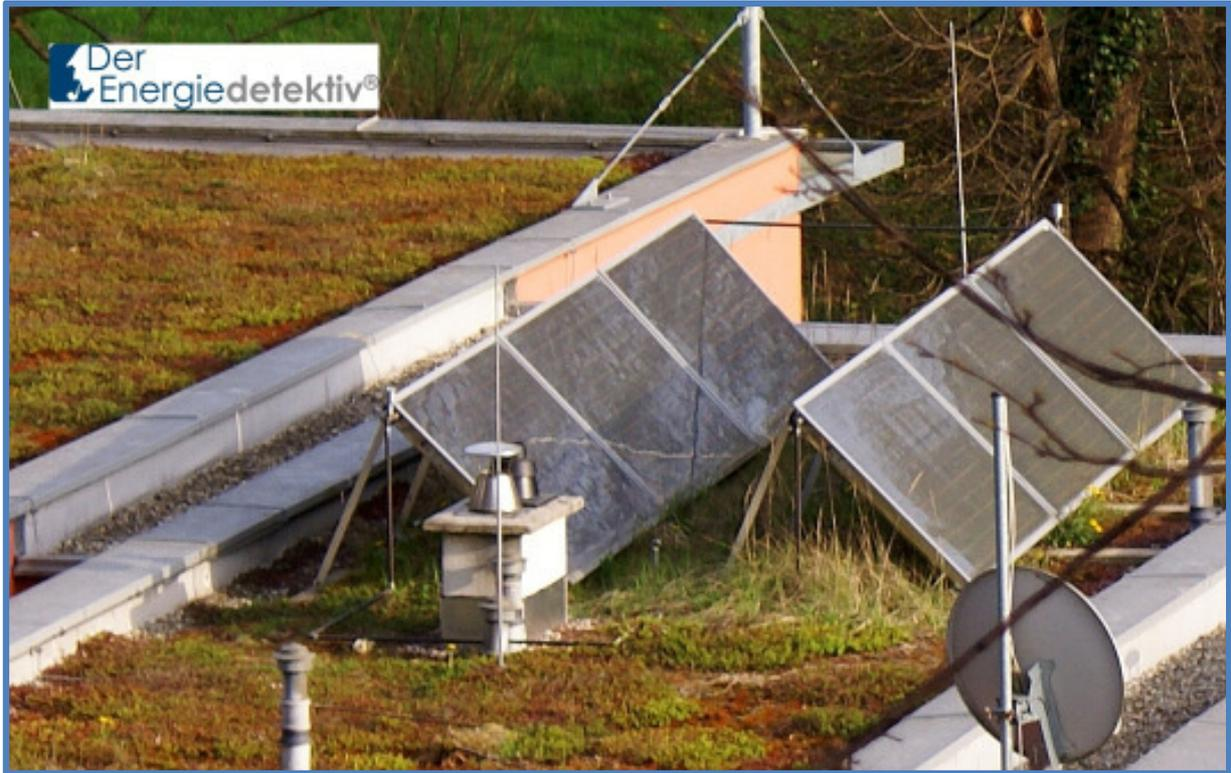
*Bild 8-15 Aufnahme einer thermischen Solaranlage mit relativ kleiner, gegenseitiger Verschattung. Die Aufnahme entstand Anfang April – also zu Beginn der Vegetationsperiode*
