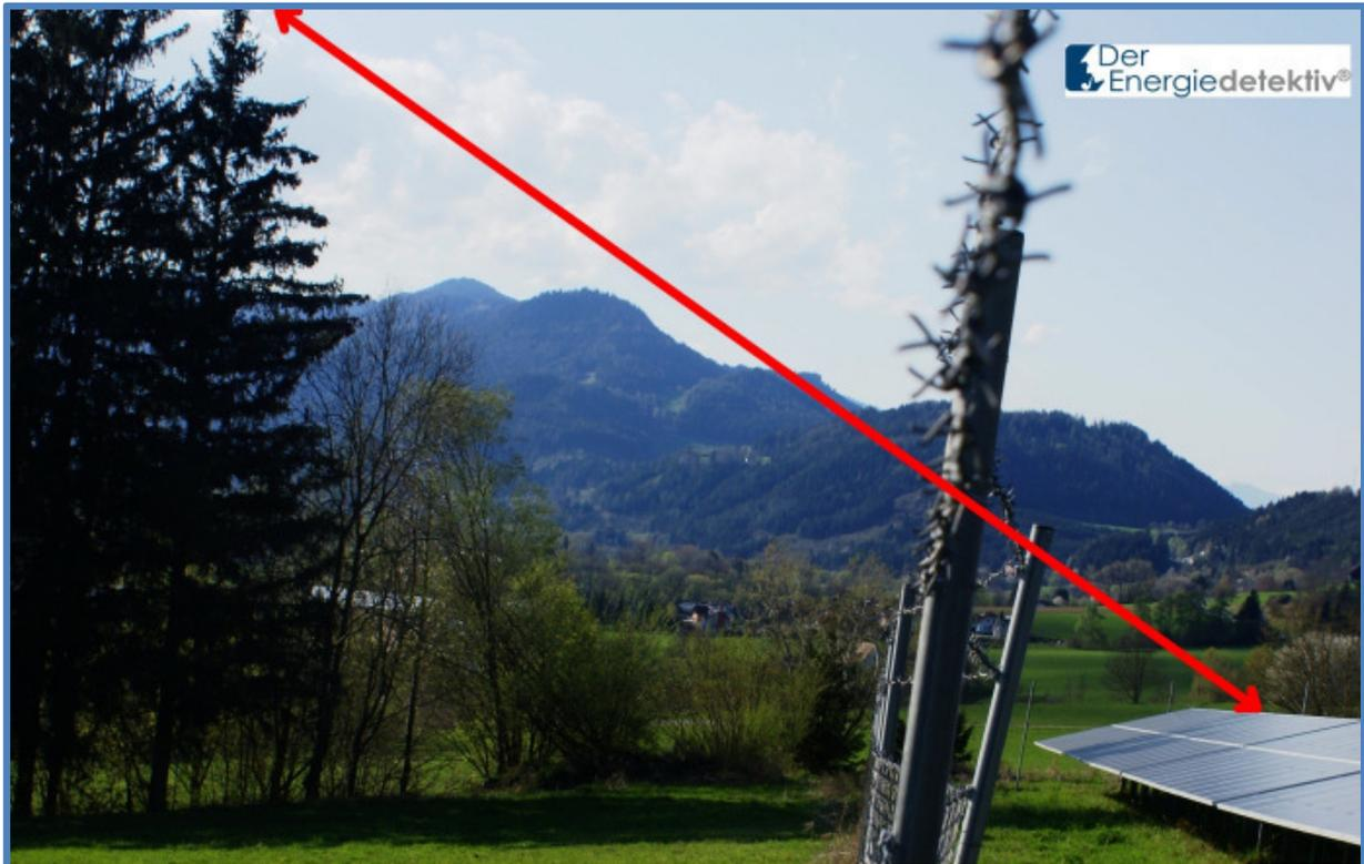
*Bild 8-40 Selbst der Stacheldrahtzaun zum Schutz der Investition in das Solarfeld ist wehrlos gegen den Schattenwurf einer größeren Gruppe von Nadelbäumen*
