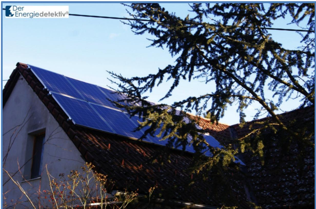
*Bild 8-30: Ein weiteres Beispiel einer massiv verschatteten Photovoltaikanlage*
